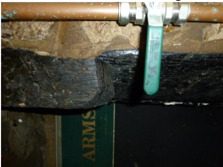
Timber lintel of Loft door .
