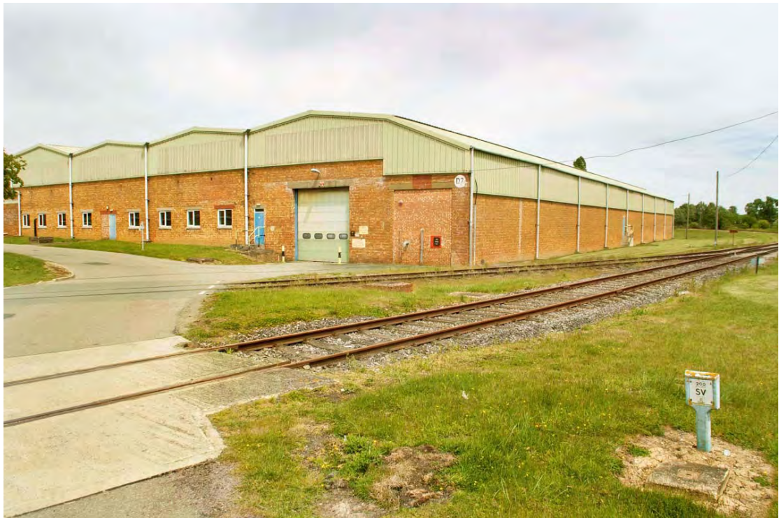
Storage Hangar D2
