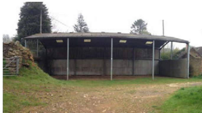
Fig. 16 - Steel pole barn
