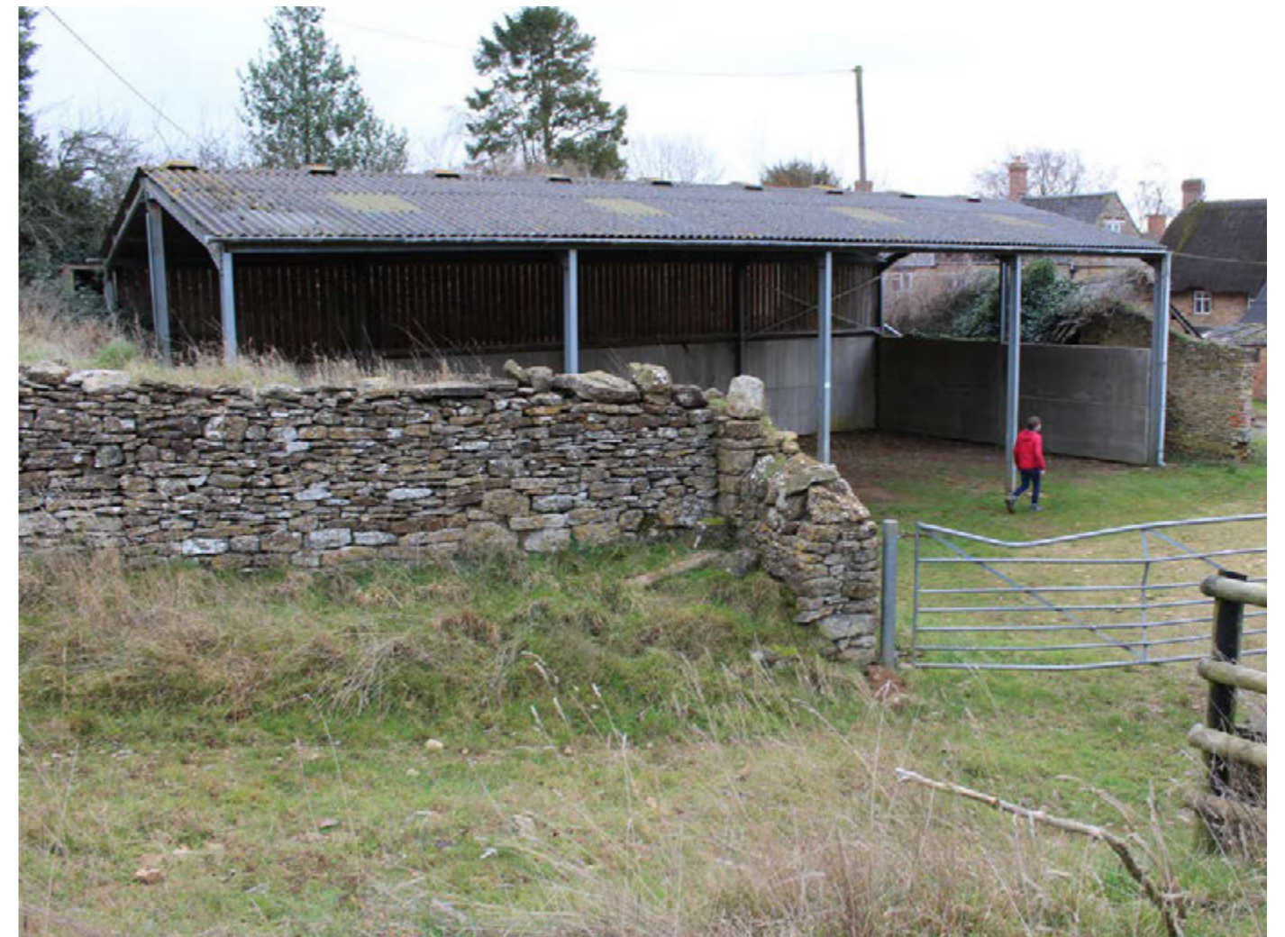
Fig. 25 - Steel pole barn
