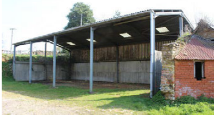
Fig. 5 - Steel pole barn
