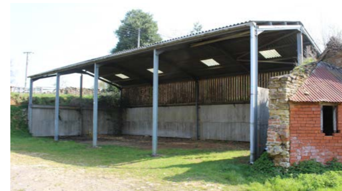
Fig. 5 - Steel pole barn
