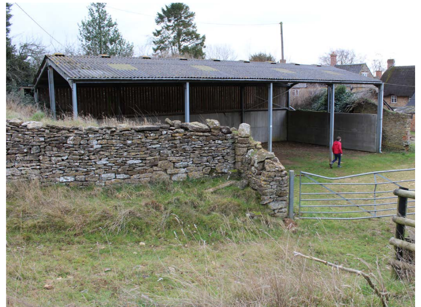
Fig. 25 - Steel pole barn
