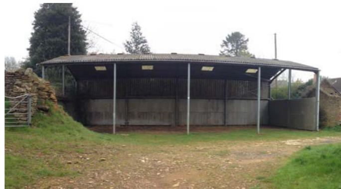
Fig. 16 - Steel pole barn
